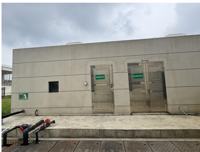
污水站总排放口
