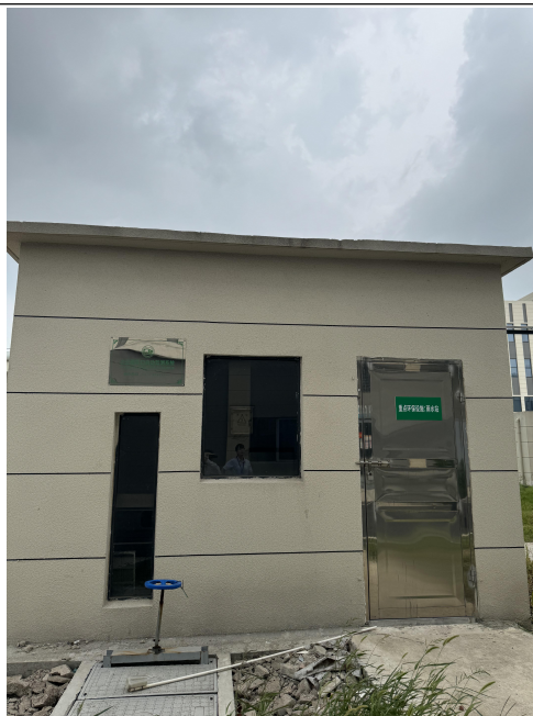
雨排口自动监测系统
